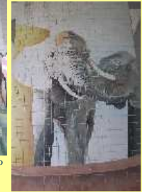
Pilier du viaduc près du Zoo de Lisbonne
